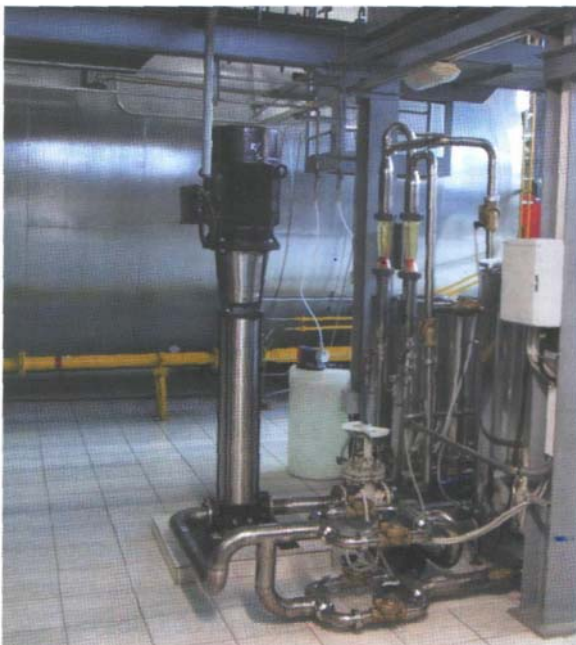
Рис. 6. Пример использования насоса CR на заводе по производству напитков в Московской области
